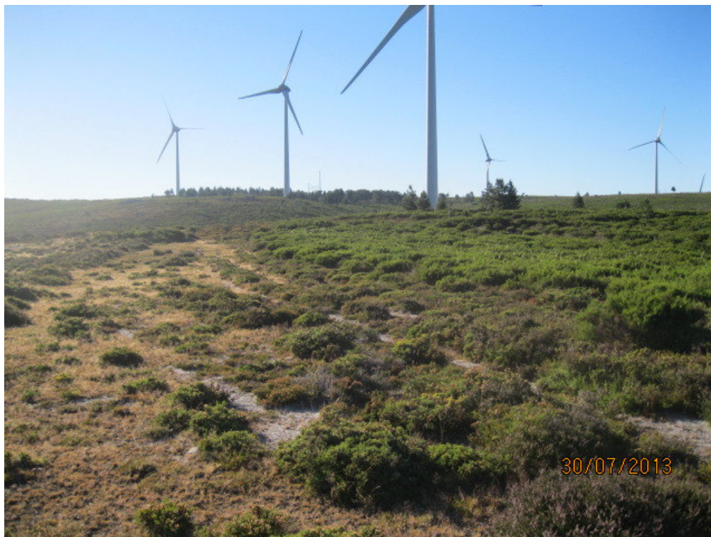
Figura 1 – Vista parcial do Sub-parque Eólico de Alto do Corisco
