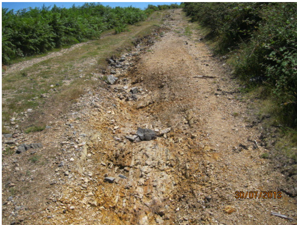
Figura 14 – Alinhamento da vala de cabos em migmatitos.
