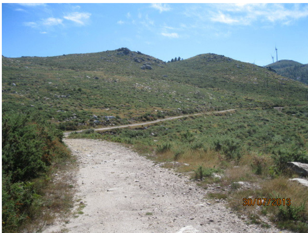
Figura 13 – Acesso a reabilitar na zona norte do sub-parque eólico.
